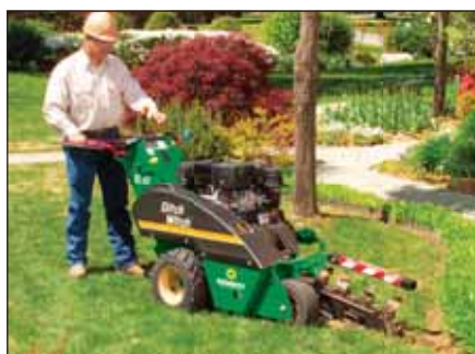
Ditch Witch 1030 11 HP
